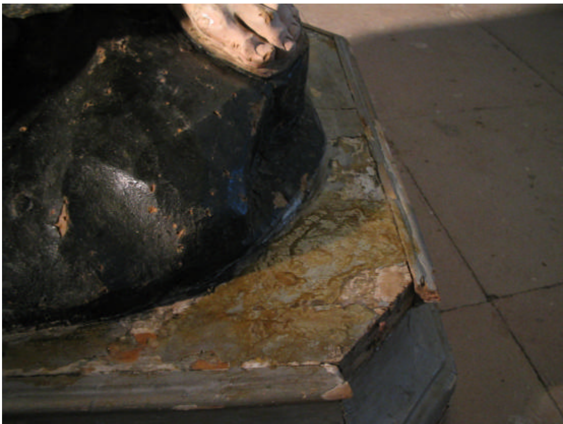
Figura 7 Pulitura del basamento della statua con l'applicazione dello sverniciatore.
